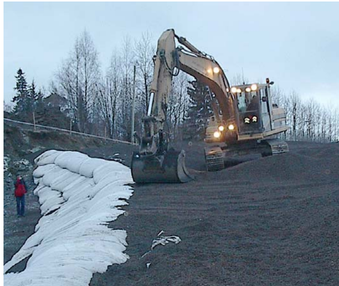
Figur 6: Gravemaskin legger masse over oppbrettet armering og planerer for neste armeringslag.
